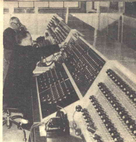
(foto sopra) Il banco piú lontano dal quadro è il banco «treni», al quale opera stando seduto il Dirigente del movimento. Sui pannelli del banco sono disposti i pulsanti di comando degli itinerari per i treni, nonché alcuni dispositivi di emergenza.
